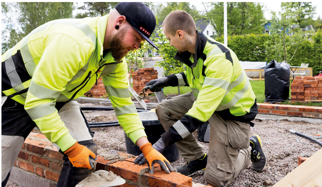
TEAMWORK. Lucas Olofsson och kollegan Richard [till vänster] bygger ett växthus.
