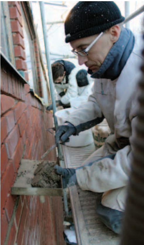
Vana och mindre vana händer reparerar fogar. Lars Karlén har egenhändigt tillverkat "brüda". Den fungerar inte för vänsterhänta Michael Bedyk
