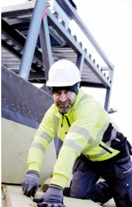
Takläggare. Cliff Lakovic har spenderat fyra veckor på tredje tornets tak.
