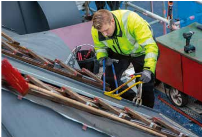
Takplåtarna falsas ihop för att hålla tätt.
