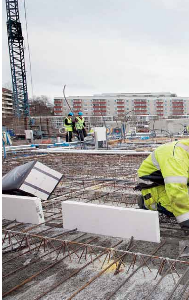
Tack vare en ny teknik som innebär att elkopplingar och VA-rör installeras på
