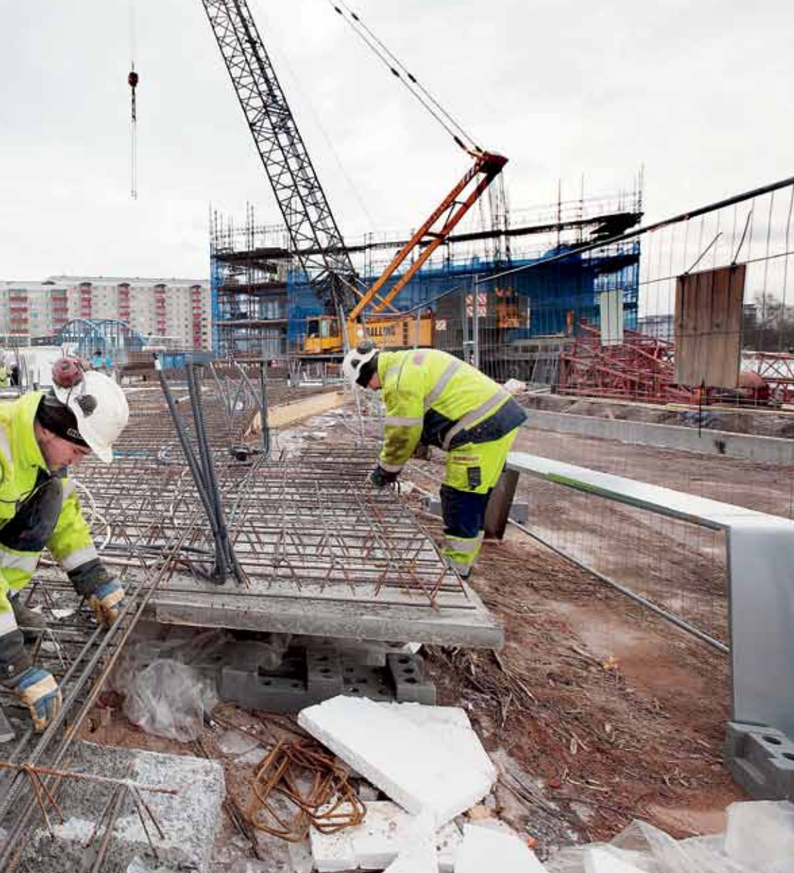
marken innan valvet lyfts upp till våningsplanet, går arbetet dubbelt så snabbt som på ett traditionellt bygge.
