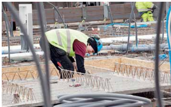
Henrik Häggbom monterar olika kopplingar på valvet innan de lyfts på plats på våningsplanet.
