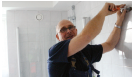
Bert Karlsson kompletterar i ett färdigt badrum och slipper damm en stund.
