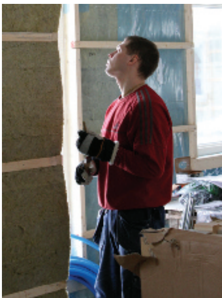
Christian Karlsson har tid för eftertanke. Byggtiden på lärlingsbygget är cirka 30 % längre än vanligt.
