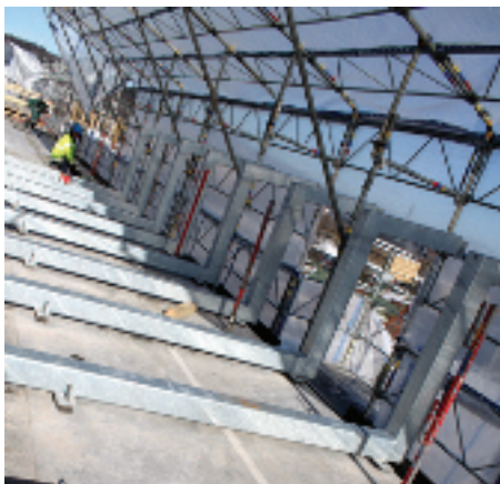
På dessa konsoler ska glasfasaden fästas. Arbetet utförs uppifrån och ner. Vädterskydd har monterats så att det inte ska regna ner i utfackningsväggarna.
