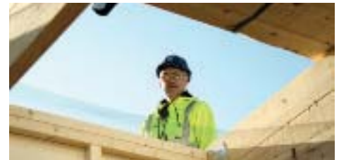
Kalle Blücker spikar tak, med havsutsikt, på den exklusiva vindsvåningen idag.
