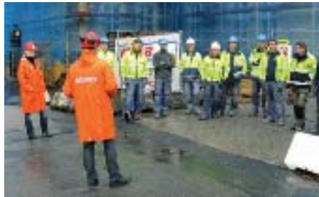
Hans Tilly fick inte komma in på Väst-Byggs arbetsplats i Borås. Han fick därför prata med byggnadsarbetarna utanför grinden.
