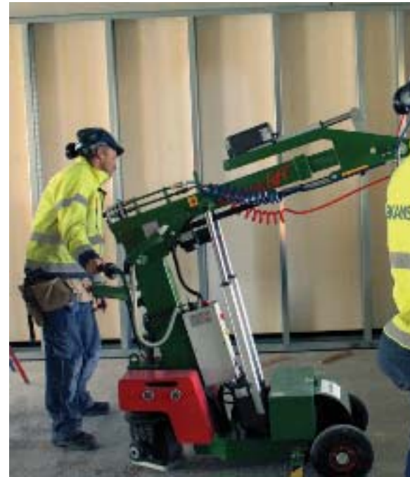
Fredrik Tengvall och Erik Hedström monterar fönster de fö.
