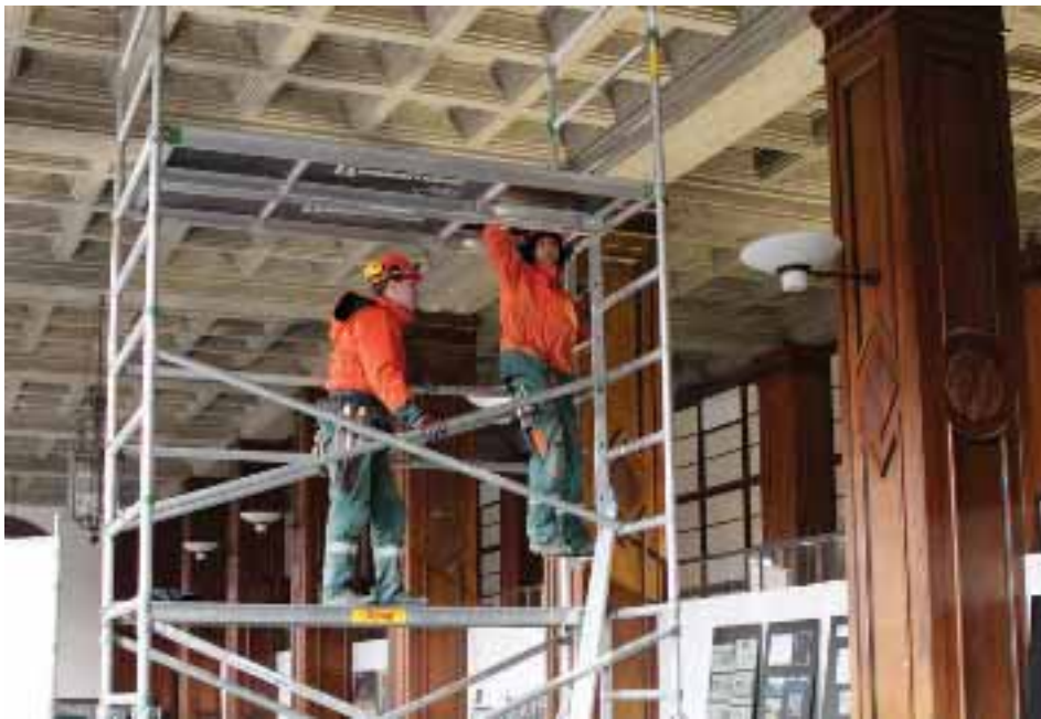
Andreas Bergman och Patrik Thörner har tagit på sig uppdraget att vara byggets skyddsbevakare. Utan att vara skyddsombud. Här river de en ställning i stora kassahallen.
