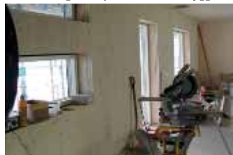
Väggarna levereras i stora block med alla hål uttagna. Det har oftast stämt på millimetern.
