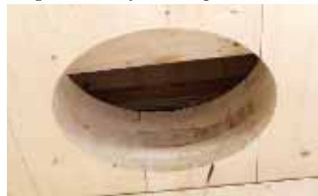
Inga problem att fästa en kristallkrona i det här bjälklaget som är 16 cm tjockt
