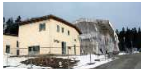
Skogsnära. Vi hälsar på innanför plasten. I maj 2011 är det inflyttning på den här etappen.
