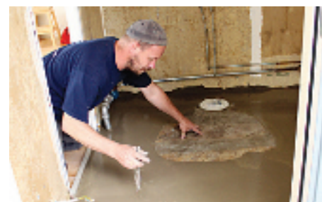
...och med yrkesvana händer fixar han ett fall i våtutrymmet. Det ska göras i ordning till tidigare skick, efter en försäkringsskada.
