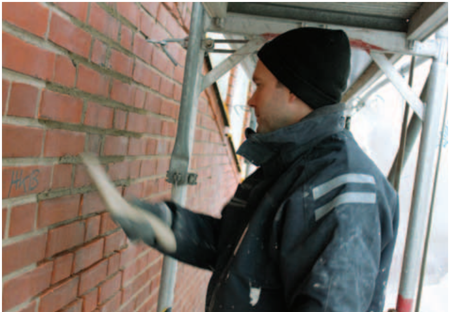
Lars Nyback putsar till fogarna han gjorde före frukostrasten. Bruket ska helst "vila" en stund på plats innan det finjusteras. Att foga är ett jobb som inbjuder till en stunds meditation.
