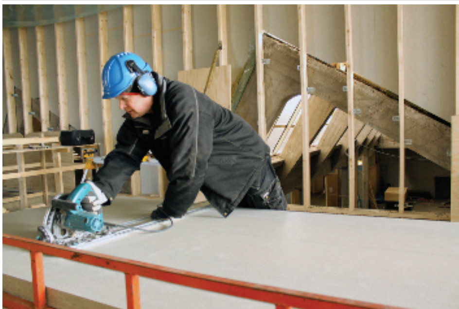
Per-Olof Johansson känner att detta är ett bygge som alla andra. I bakgrunden en av "sågtänderna"
