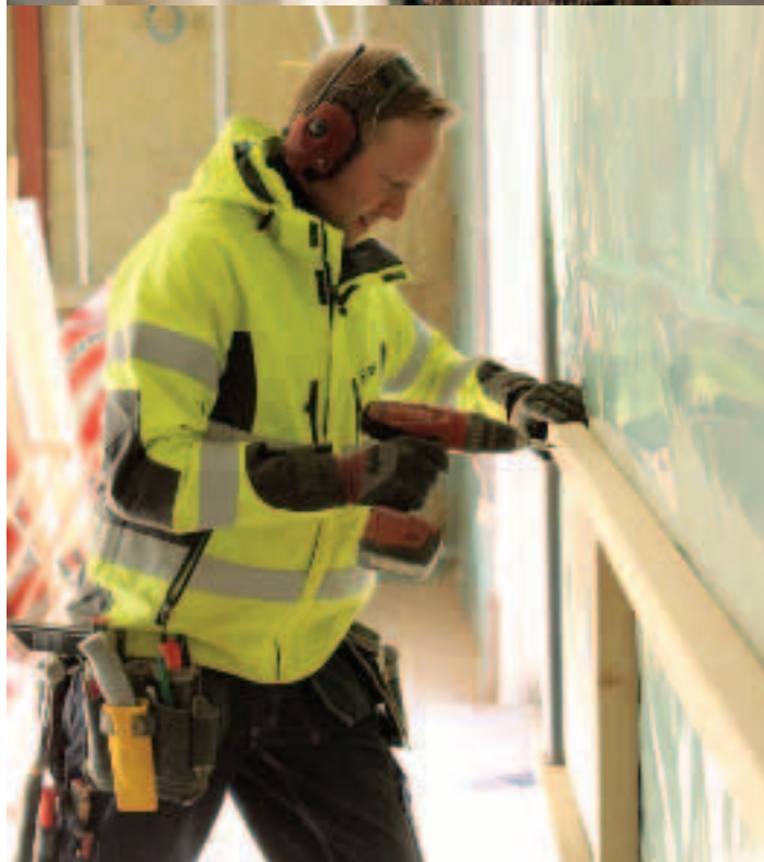
Full aktivitet på olika håll. Kay Sundh fäster reglar...
