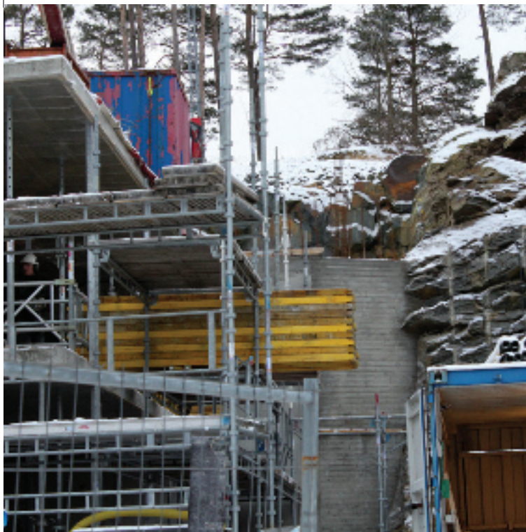
Jan Ingvarsson sätter väggform och kör kran, Henrik Sablin lägger valv, Tomas Larsson armerar, Jerry Eriksson river stämp och Lars Svahn är lagbas och armerar mot berg på detta bygget. Alla är, liksom de andra i laget specialiserade på sina arbetsuppgifter. Men de hanterar det mesta på bygget. Det brukar ge bra resultat vid ackordsmätningarna.
