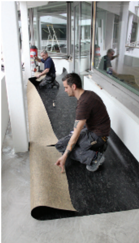
Georg Johansson och Kristoffer Kinberg limmar matta på en balkong runt ljusgården i Skanskas ny- och ombyggda hus nära älven. De mäter också sina jobb med hjälp av ackordslistan. Resultatet brukar bli bra.
