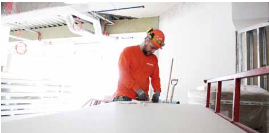
Gips i massor. Adam Ekemalm gipsar undertaken på de lägre våningarna.
