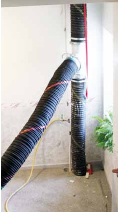
Steg 3. Krosset leds ut genom ett hål.
