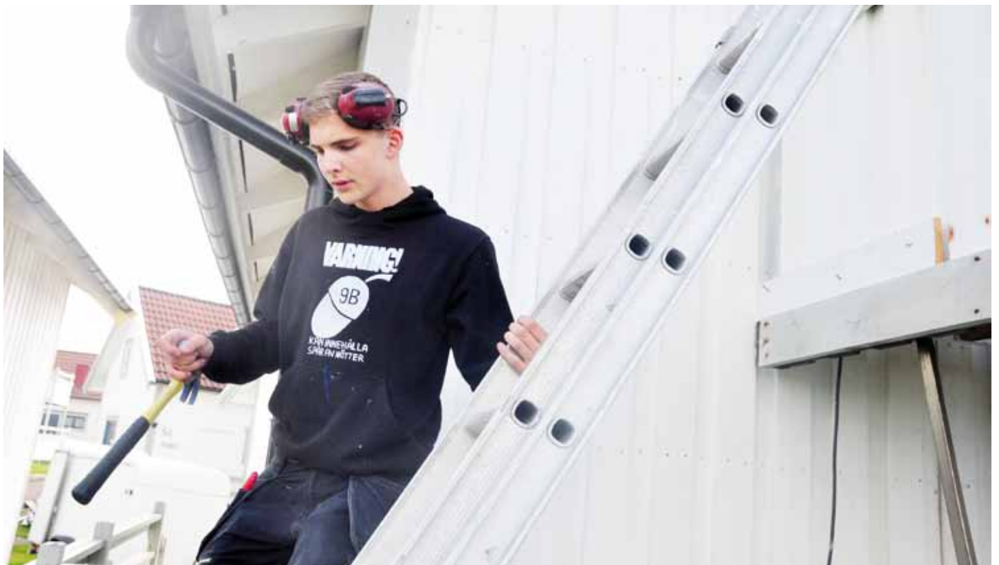
Fasadarbete. Ludvig Martinsson renoverar fasaden på en av fritidsstugorna på Gullholmen.
