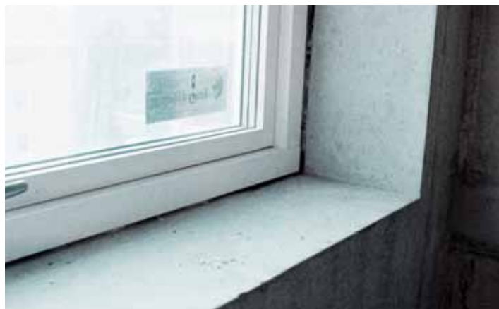
Tjocka väggar. Ytterväggarna är 440 millimeter tjocka i husen. Normal tjocklek är runt 300 millimeter.
