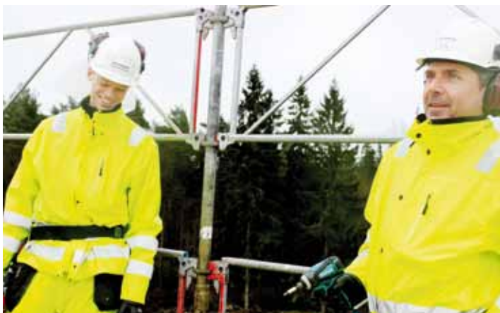
Takbyggare. Daniel Lundqvist och Vesa Råberg kämpar med regnet när de bygger takstolar på det ena huset.
