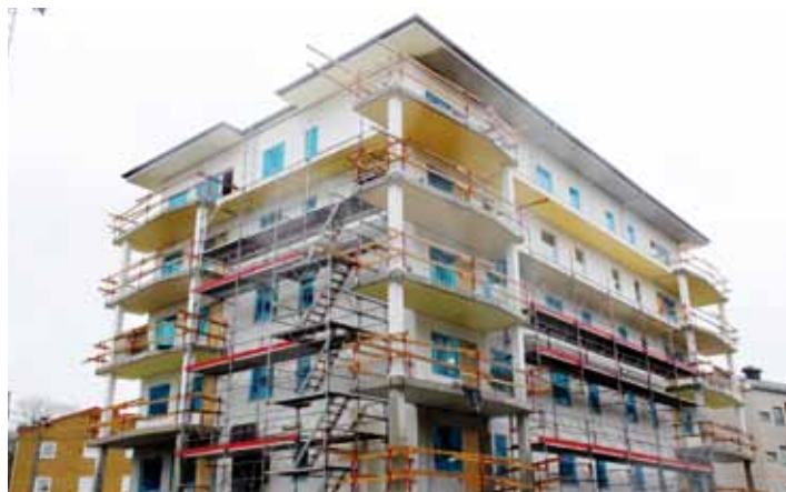
Arbete pågår. Först i juni nästa år kommer de första lägenhetsköparna att kunna flytta in.
