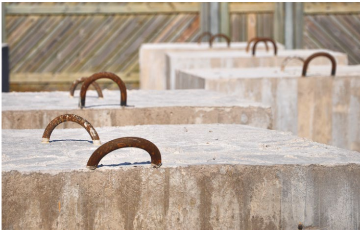
Egengjutna ankare. 10 stycken betongankare ska hålla flotten och bryggan på plats. Totalt har 24 ton betong gått åt till gjutningen.
