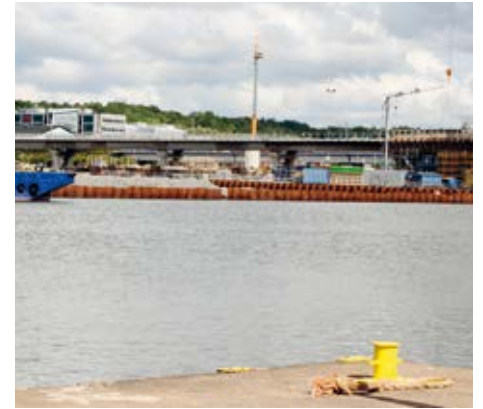
Tunnelsträcka. Totalt blir tunneln 500 meter lång och på Hisingsidan blir infarten strax öster om Ringön.
