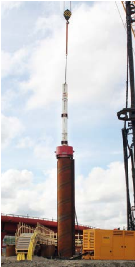
Pålning pågår. De 30 ton tunga rören pålas ner i marken och bildar ett schakt där de tre sänktunneldelarna ska gjutas.
