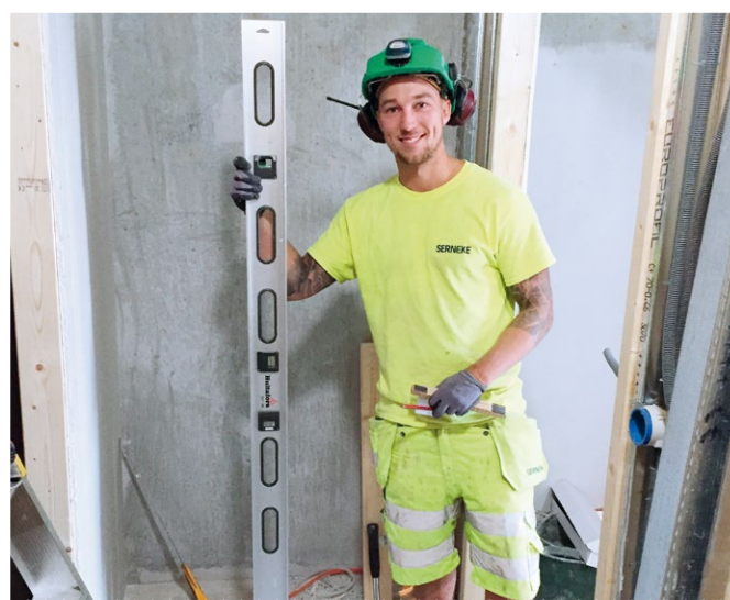
24 augusti. Mattias Hellqvist på Serneke arbetar på ett bygge i Gårdsten i Göteborg. Han tycker att arbetsmiljön och säkra arbetsplatser är viktigt.
