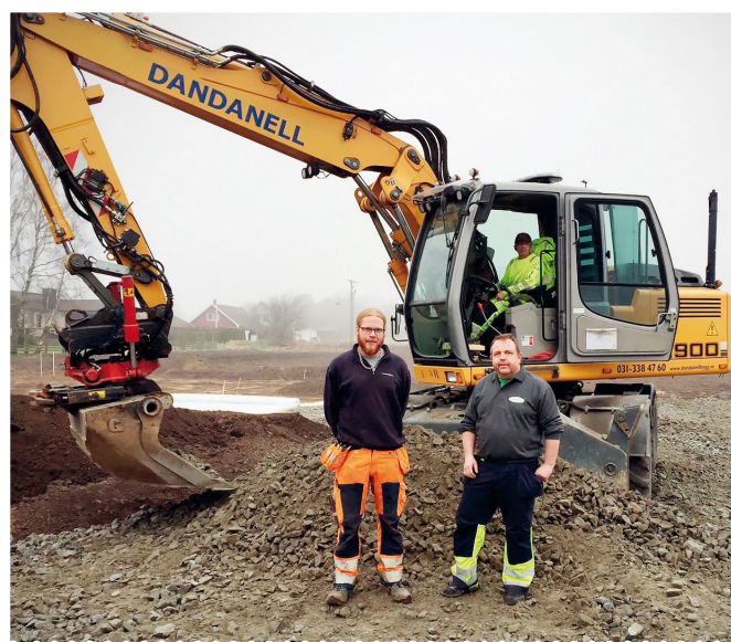
6 april. Byggnads Väst på arbetsplatsbesök på Dandanelns arbetsplats där vi håller info om avtalsrörelsen.
