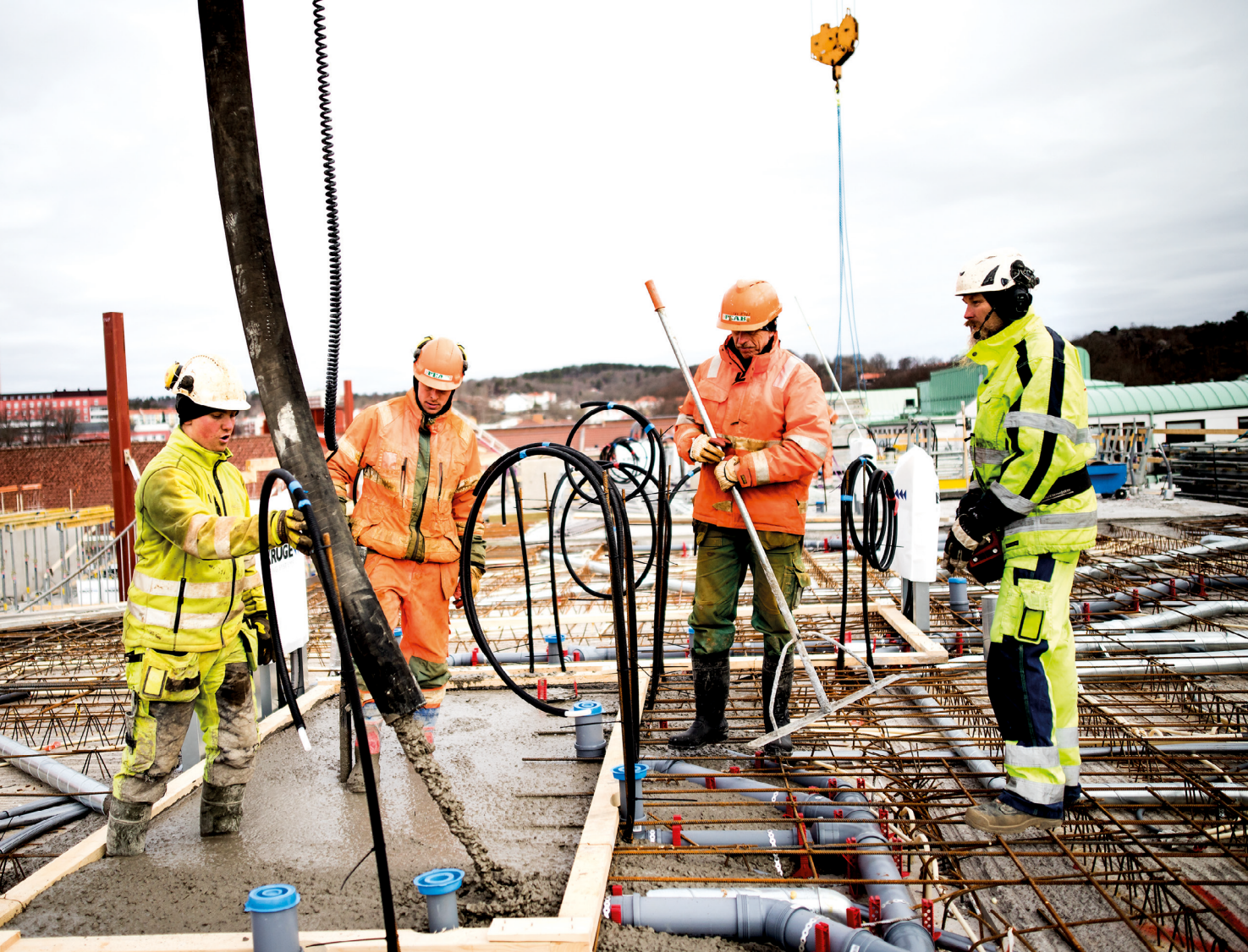
ALLA VÄNTAR PÅ BETONG. Har fyller Jörgen Wagerland på betong i ett badrum på ett bygge i Uddevalla. Kranen som pumpar upp betongen ur bilen har en räckvidd på 47 meter,
