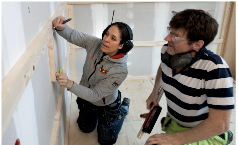
STOLT. Som lärling är det såklart kul att vara med och bygga klart ett hus. Katarina Adolfsson Gran har bland annat varit med och gjort väggen i bakgrunden.
