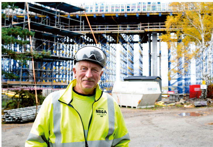
SPECIELLT BYGGE. Betongarbetaren Krzysztof Lisiecki vid det nya vattentornet i Varberg – en speciell byggnad som fått mycket uppmärksamhet.
