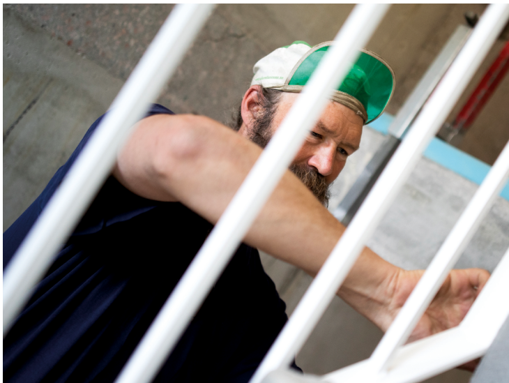
FÅSTER TRAPPRÄCKE. Martin Johansson skruvar fast ett trappräcke i ett nytt bostadshus i Halmstad.
