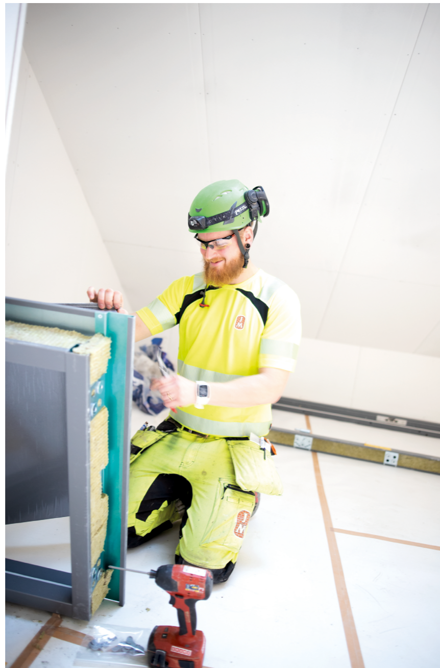
MONTERAR LUCKOR. Josef Arvidsson har varit på Kviberg under hösten och byggt bostadshus. När vi träffades var det slutspurten.
